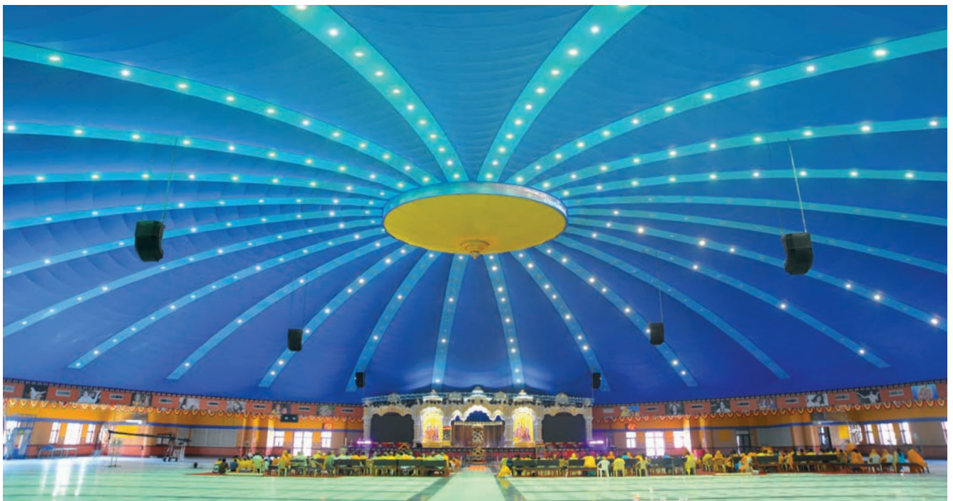
Basotect® (bedeckt mit blauem Stoff) wurde als Schallabsorber an der Betonkuppel einer der größten Gebetshallen in Indien befestigt.
